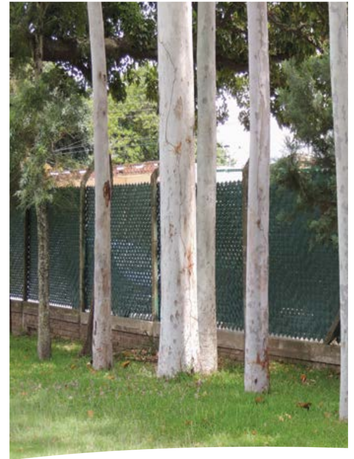
Colocación de láminas metálicas de protección visual en el enmallado sobre la avenida Caparuch, para darle seguridad y privacidad a la cancha de golf.
